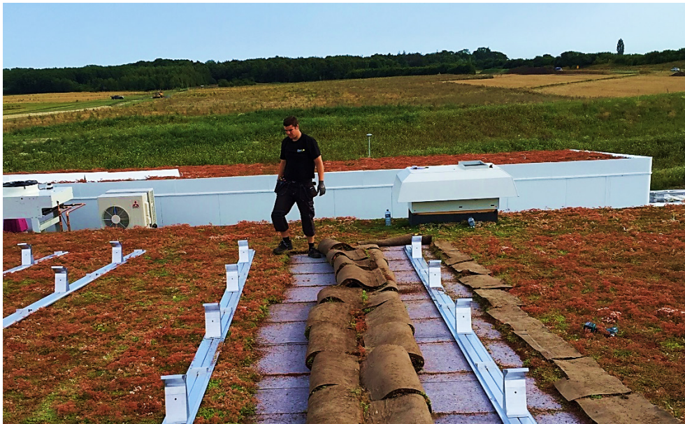
Figur 22 Sedummattan veks åt sidan och sedan lades skensystemet ut ovanpå det vattenhållande lagret.
