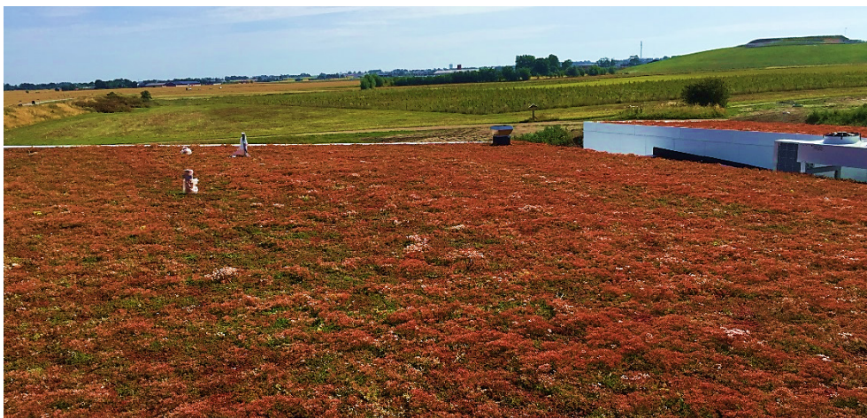
Figur 20 Sedumtaket före installationen av solceller.
