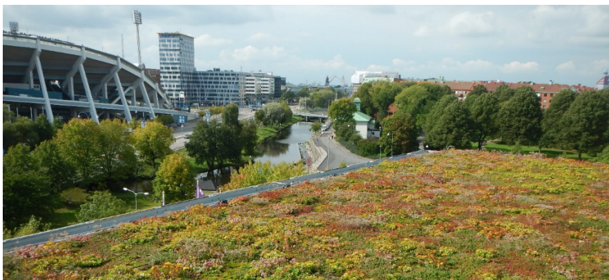
Figur 7 Extensivt tak på Rantorget Göteborg (Bild: Veg Tech)
