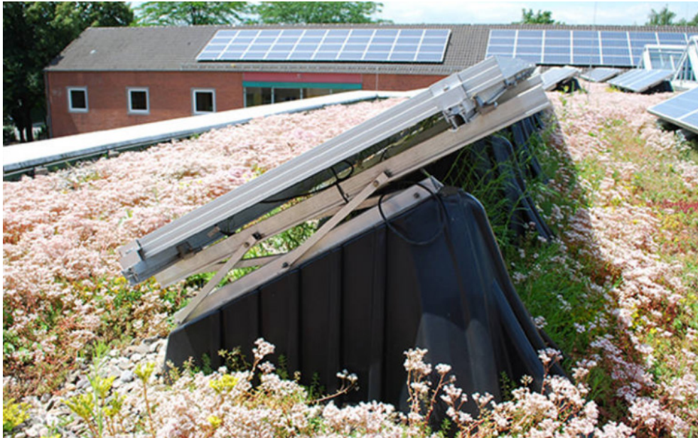
Figur 16 Sun-Root monteringsystem (Bild: Optigreen)
