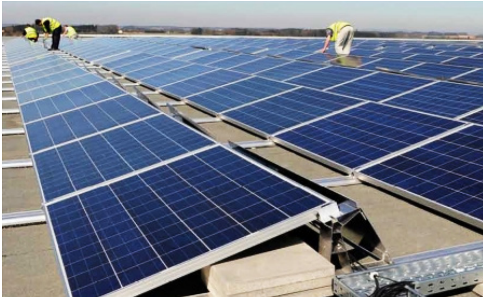
Figur 27 Ballastsystem på platt takyta.
