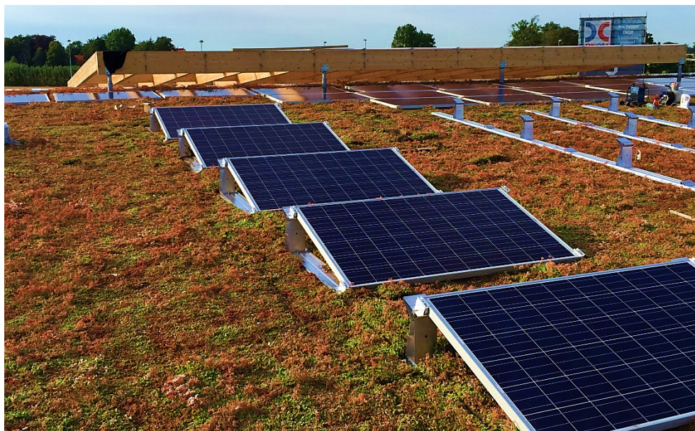
Figur 24 Sedan monterades solcellsmodulerna.
