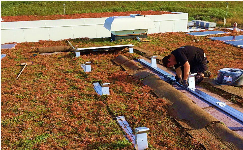
Figur 23 Sedummattan veks sedan tillbaka igen, ovanpå skenorna, på ytorna mellan modulraderna.
