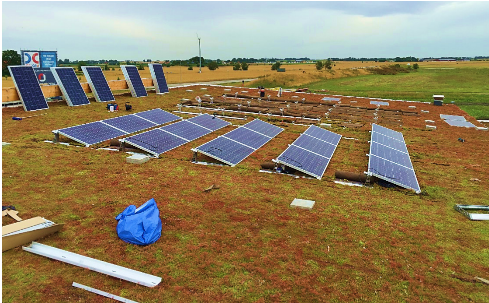
Figur 25 Till sist lades ballastblock ut på skenorna.
