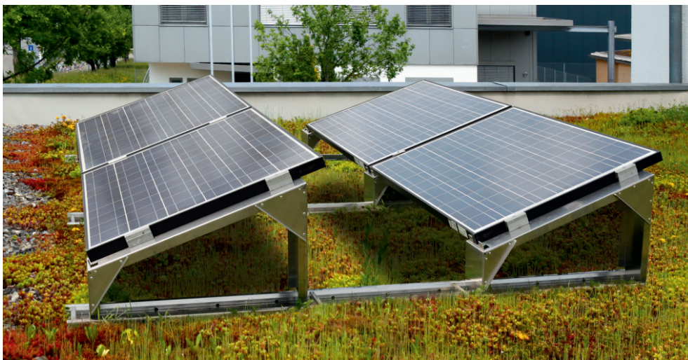
Figur 14 Duraklick GR 100/20 monteringsystem (Bild: Optigreen)
