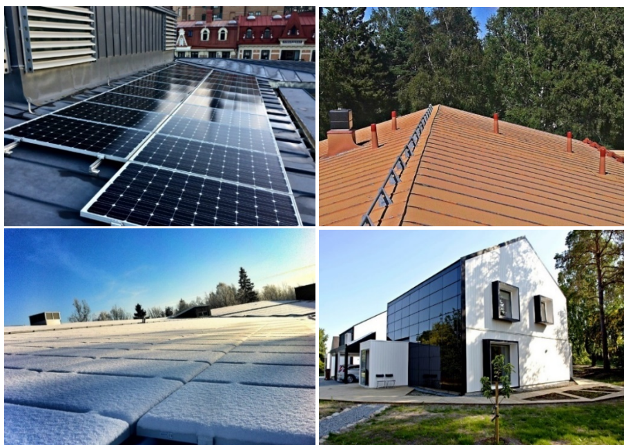
Figur 2 Solceller kan exempelvis skuggas av fläktrum, luftningsrör eller snö. Av estetiska skäl kan det ändå vara rimligt att täcka hela ytor med solceller, trots skuggning, som på huset nederst till höger (Foto: Solkompaniet/A-hus).
