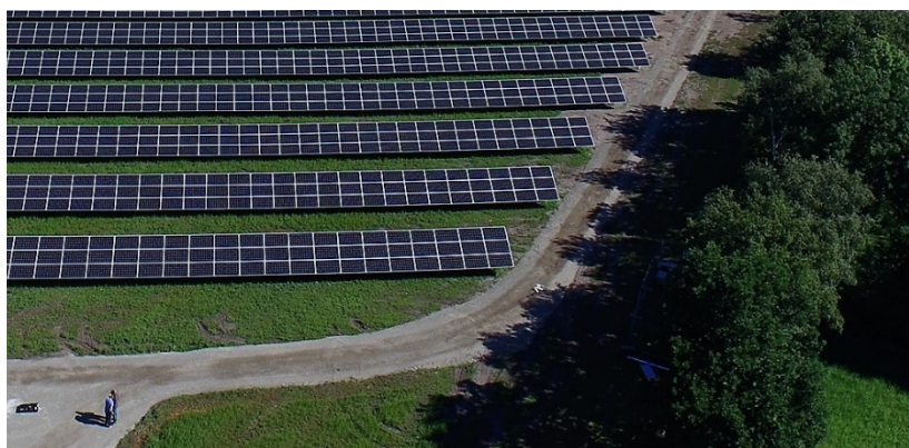
Figur 1 Solceller i Varberg placerade med avstånd till träd, och mellan rader, för att minimera inverkan från skuggning.
